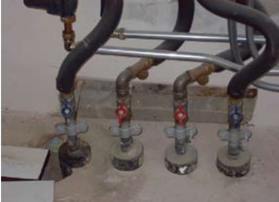
Afsluiters onder afleverstation staan open
